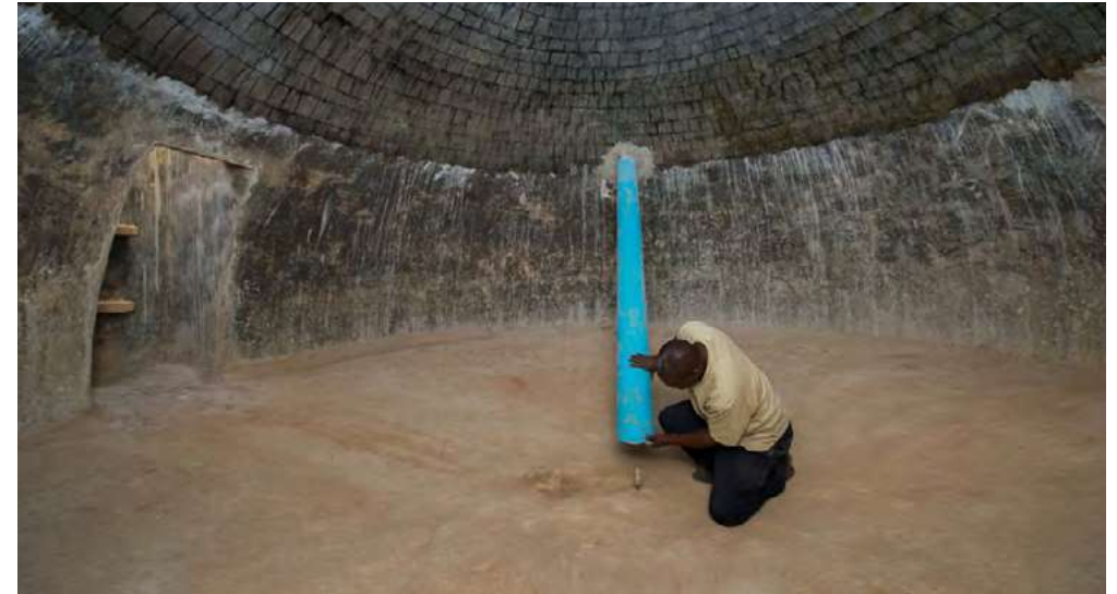
Inside the Chazanga biogas digester
