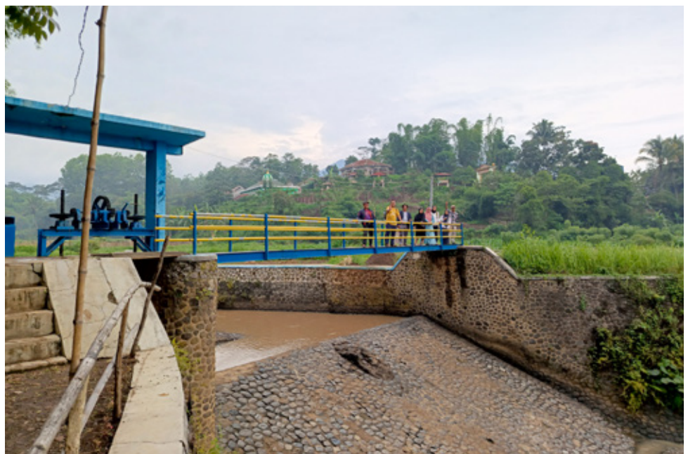
Gambar 3: Jembatan yang telah diperbaiki untuk melindungi dan meningkatkan kualitas/kuantitas air permukaan di dekat mata air KPSPAM Mikti Binangkit, Kecamatan Sukawening, Kabupaten Garut
