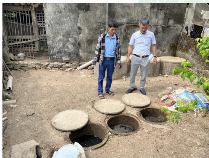
Ử dụng cả 3 bể; Quá công kênh (6 bể)
