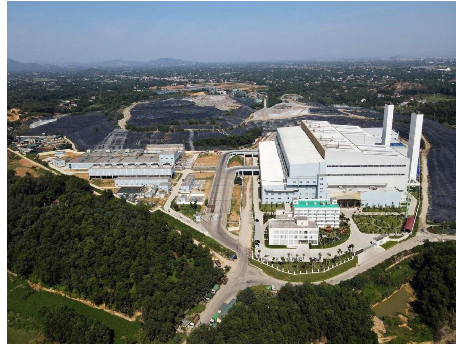
Nhà máy Điện rác Sóc Sơn
